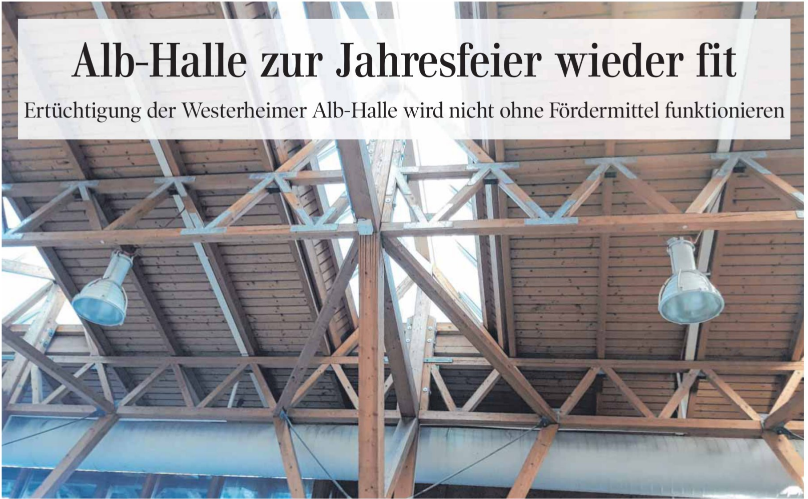
Mit solchen Metallplatten wird die Dachkonstruktion der Westerheimer Albhalle stabilisiert.
